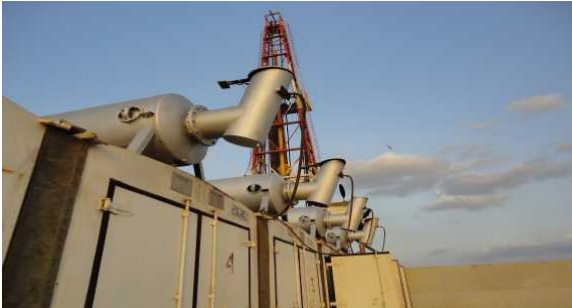
شکل (۱) لاین های آب متصل به خروجی دهانه اگزوز دیزل ژنراتور ها قابل مشاهده می باشد.
